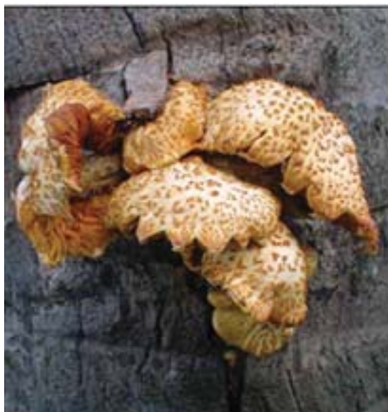
Figura 25. Fungo decompositor de madeira - Foto: Clóvis Franco
