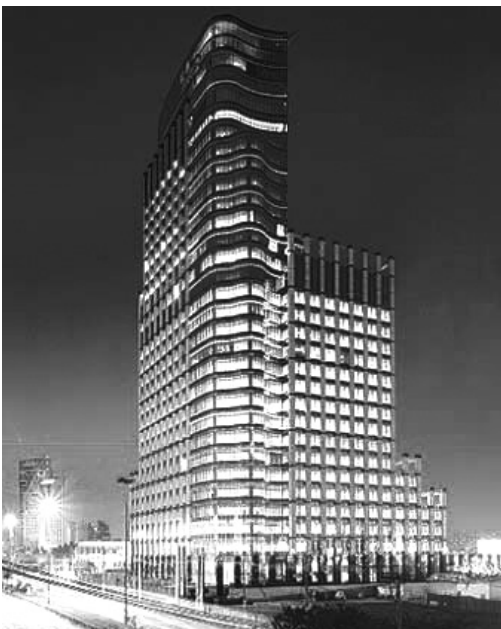
Figura 5 - Sede brasileira do Bank Boston, em São Paulo (Fonte: http://www.arcoweb.com.br ).
