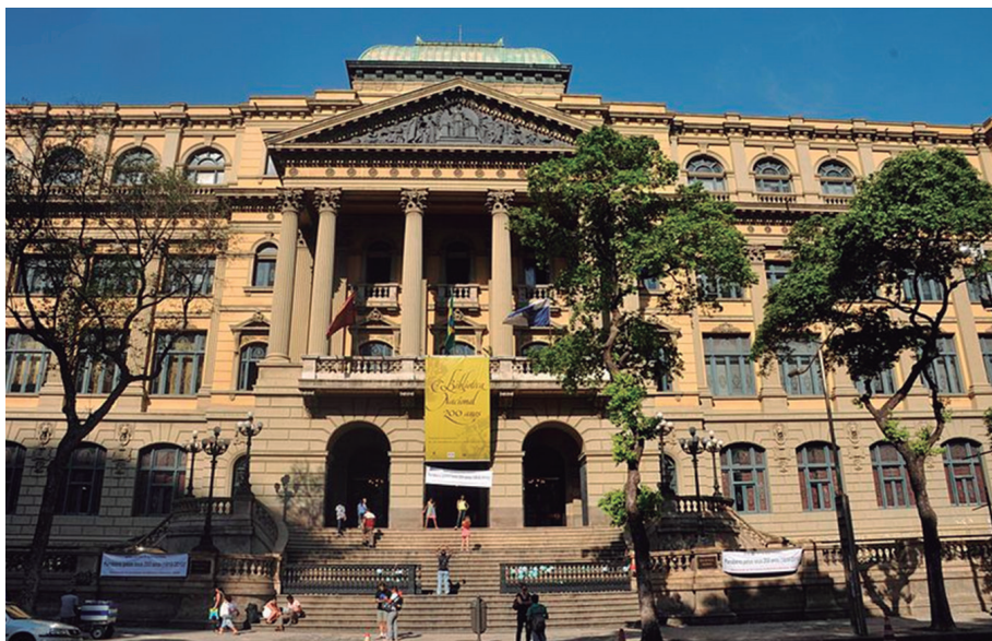
Figura 25 - Fachada da Biblioteca Nacional do Rio de Janeiro
