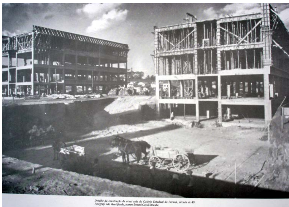
FIGURA 14 - CONSTRUÇÃO DO PRÉDIO DO COLÉGIO ESTADUAL DO PARANÁ - CURITIBA, DÉCADA DE 1940. FONTE: ACERVO ERNANI C. STRAUBE, DIGITALIZADO E DISPONÍVEL NO ACERVO DO CENTRO DE MEMÓRIA DO CENTRO DE MEMÓRIA DO COLÉGIO ESTADUAL DO PARANÁ (CMCEP).
