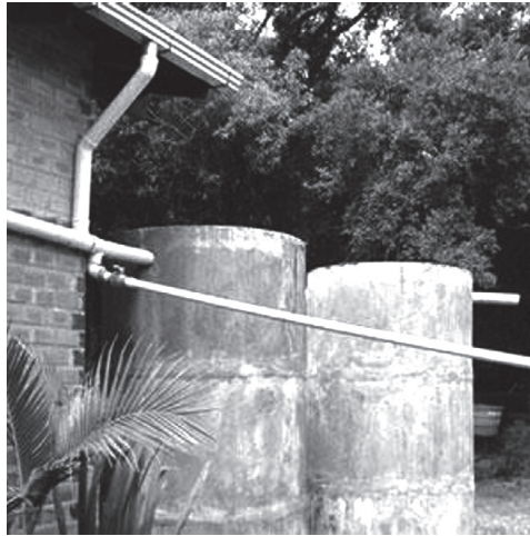
Figura 13: Cisterna para armazenar água da chuva Fonte: Sítio Castañeda (2008)
