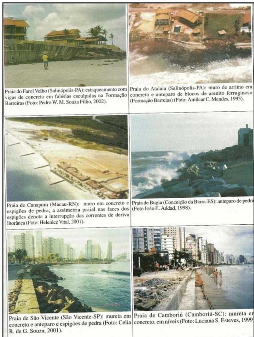
Figura 9.9 – Exemplos de obras de proteção costeira no Brasil. (Fonte: SOUZA et al., 2005.)
